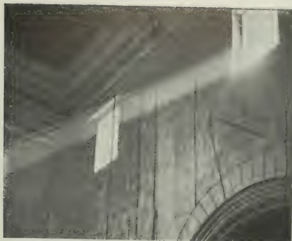
Fig. X. — Finestrals del trifori abans de sa restauració. (Fot. A. Oromí.)
